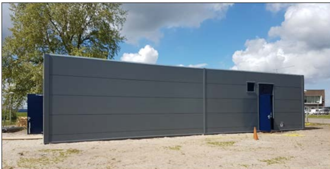
Figuur 2.7 Voorbeeld schakelstation
