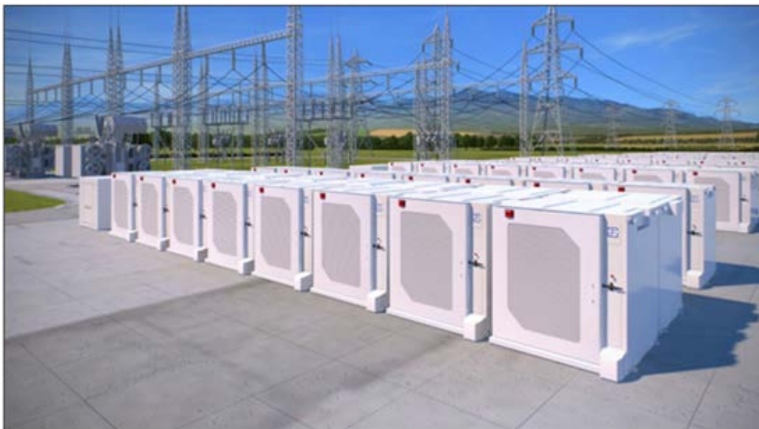
Figuur 2.12 Voorbeeld energieopslagsysteem met batterijen in de open lucht [bron: ESB/Fluence]
