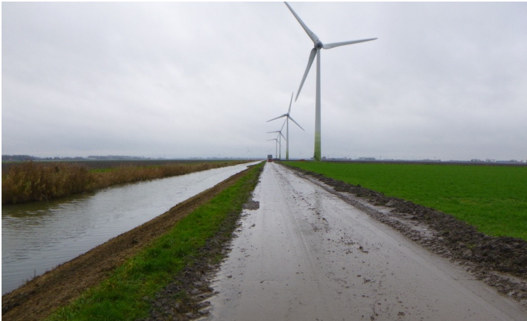
Figuur 2: Windpark Hondtocht gezien vanuit het noorden.
