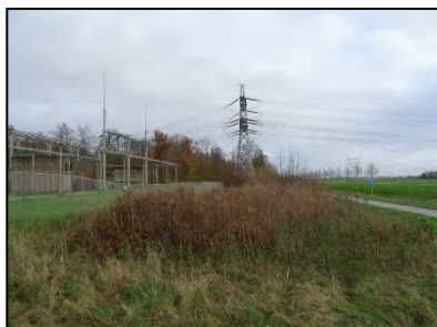
Figuur 4. Onderzoekslocatie vanuit het westen gezien vanaf de oprit van het onderstation.
