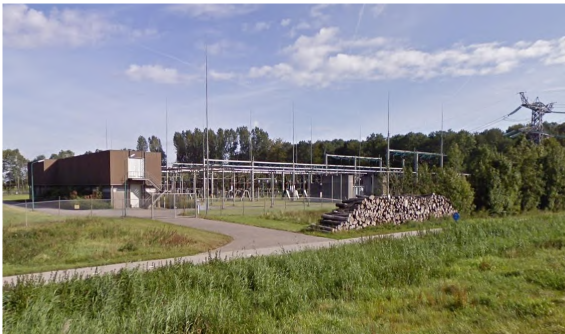
afbeelding 4: aanzicht onderstation vanaf de N309 Dronterweg (bron: google streetview)
