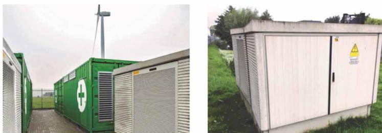
Figuur 11. Impressie transformator-gebouwtjes
