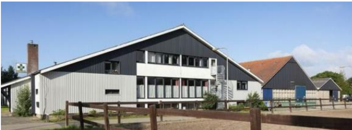
Foto 5: Huidige opstallen (nokhoogte maximaal 8m)
