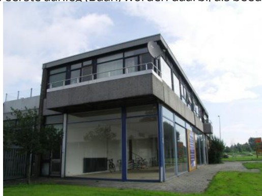
afb. 12 Tractorshowroom aan de Baan
