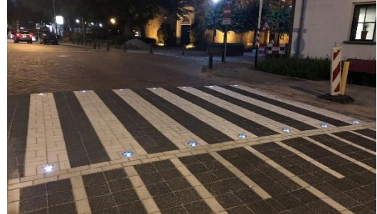
Figuur 8 Dynamische wegdekverlichting (Inbouw solar wegdekreflector, sd)
