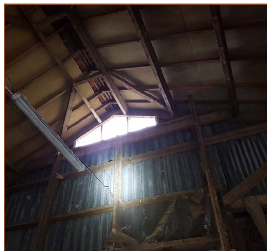
Afb. 2.6: Binnenzijde kopgevel met de enkellaags golfplaten afwerking.
