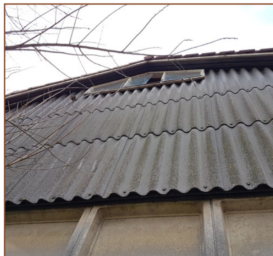
Afb. 2.4: Detail buitenzijde kopgevel. Vleermuizen hebben toegang tot de ruimte tussen pannen en dakbeschot en tot de ruimte achter boeidelen.
