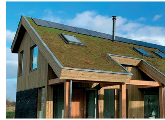
groene daken met geïntegreerde zonnepanelen
