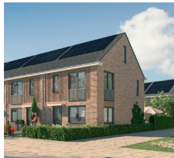
verschil in baksteenpatroon tussen begane grond en verdieping
