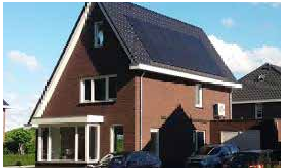
Voorbeeld van Indak" zonnepanelen op zuidzijde
